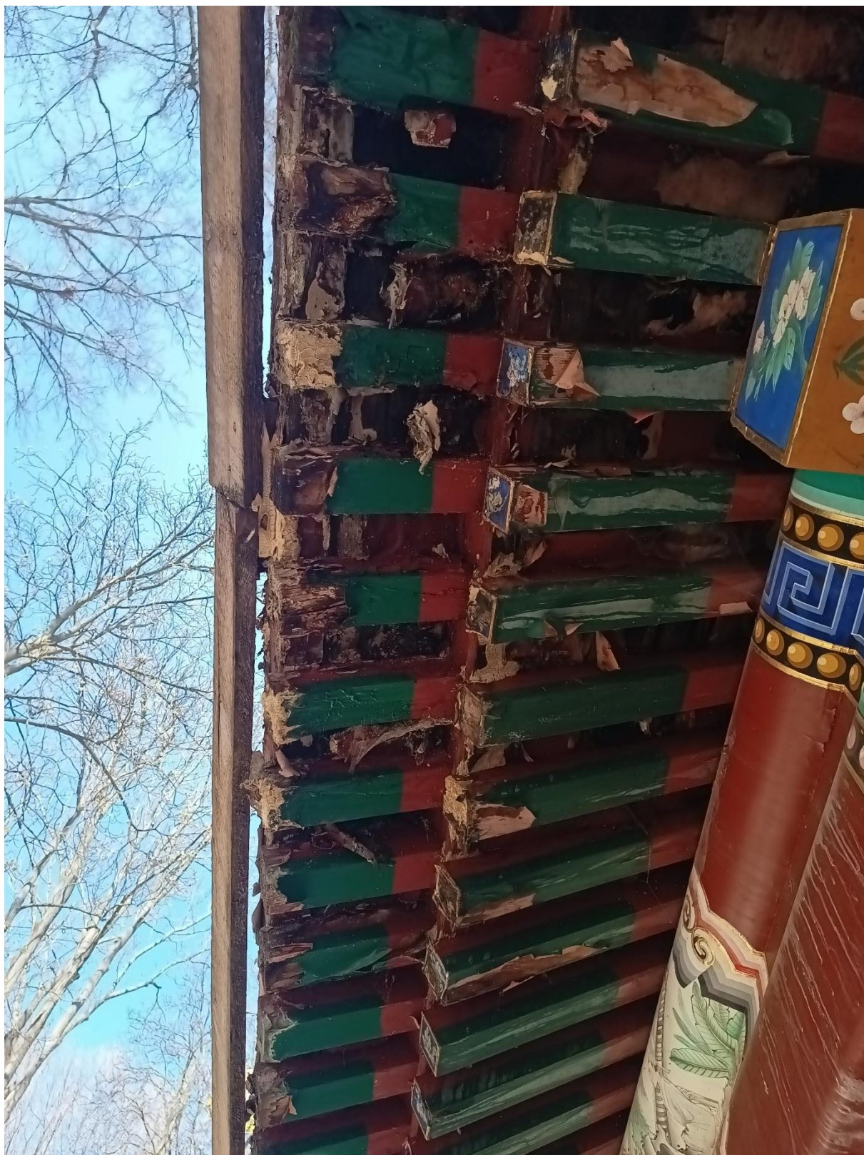
Zdjęcie 11. Fibroporia vaillantii na krokwiach pawilonu chińskiego (fot. Marta Wrzosek)
