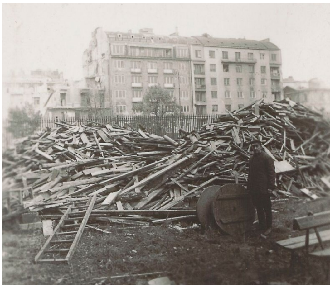
1. Fotografia Janiny Mierzeckiej ukazująca dziedziniec boczny Muzeum Narodowego w Warszawie podczas prac remontowych gmachu, 25 października 1946 r.
